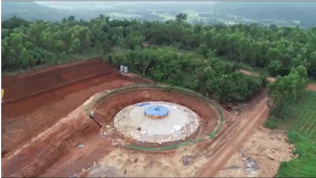
จุดที่เยี่ยมชม อยู่ระหว่างการบ่มคอนกรีตของฐานรากด้วยฉนวนความคุมอุณหภูมิ ระยะเวลา ๗ วัน
