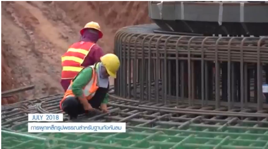
การผูกเหล็ก สำหรับทำฐานรากกึ่งหันลม
