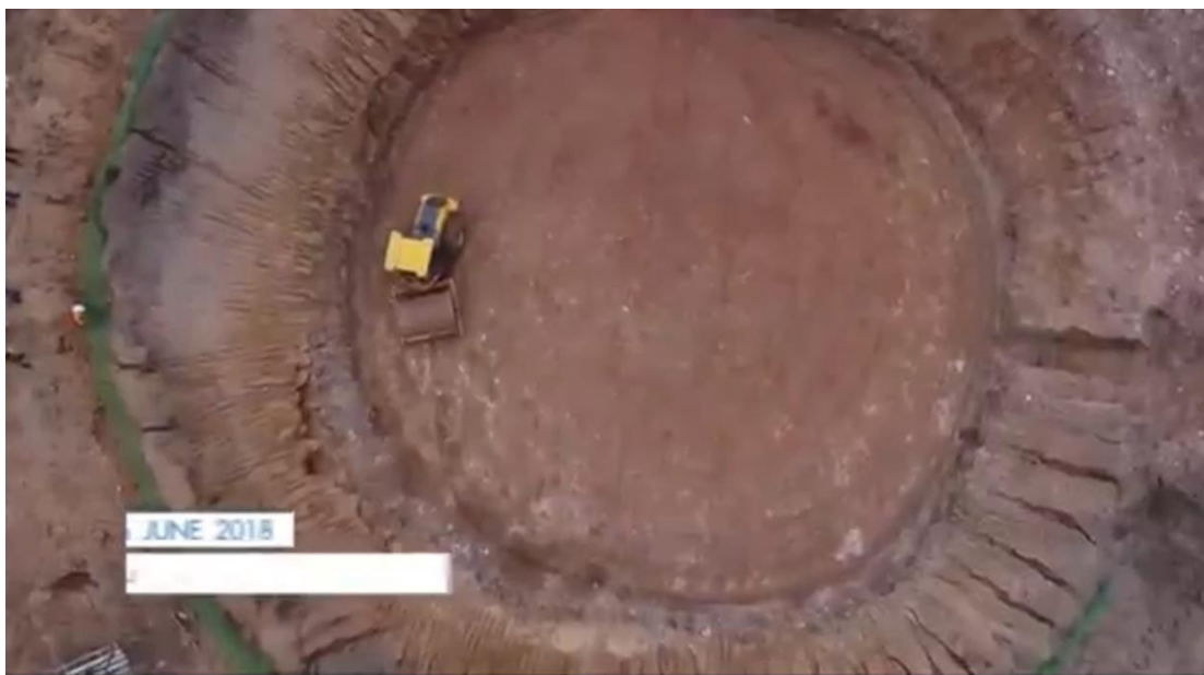
มิถุนายน ๒๕๖๑ ขุดพื้นที่สำหรับฐานรากกังหันลม บดอัด
