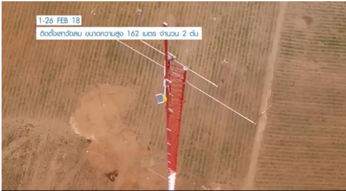
๑-๒๖ กุมภาพันธ์ ๒๕๖๑ ติดตั้งเสาวัดลมขนาดความสูง ๑๖๒ เมตร จำนวน ๒ ต้น (เดิมเสาวัดลมมีจำนวน ๒ ต้น)
