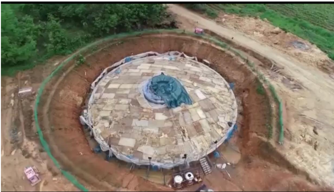
การบ่มคอนกรีตเพื่อให้ได้ความแข็งแรงของคอนกรีตที่เหมาะสม
