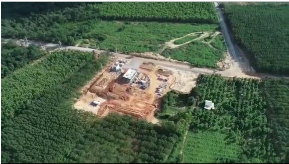
การติดตั้งหม้อแปลงไฟฟ้า ภายในอาคารสถานีไฟฟ้า
