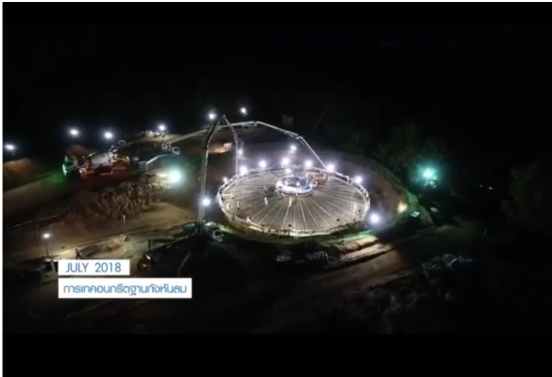
การผูกเหล็ก สำหรับทำฐานรากกังหันลม
