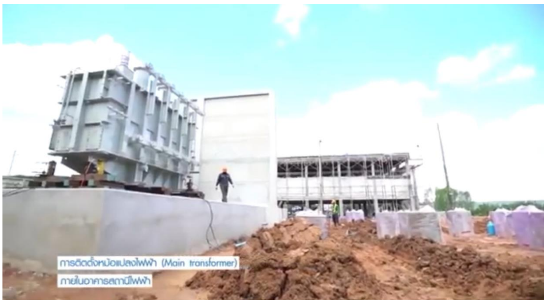
การติดตั้งหม้อแปลงไฟฟ้า ภายในอาคารสถานีไฟฟ้า
