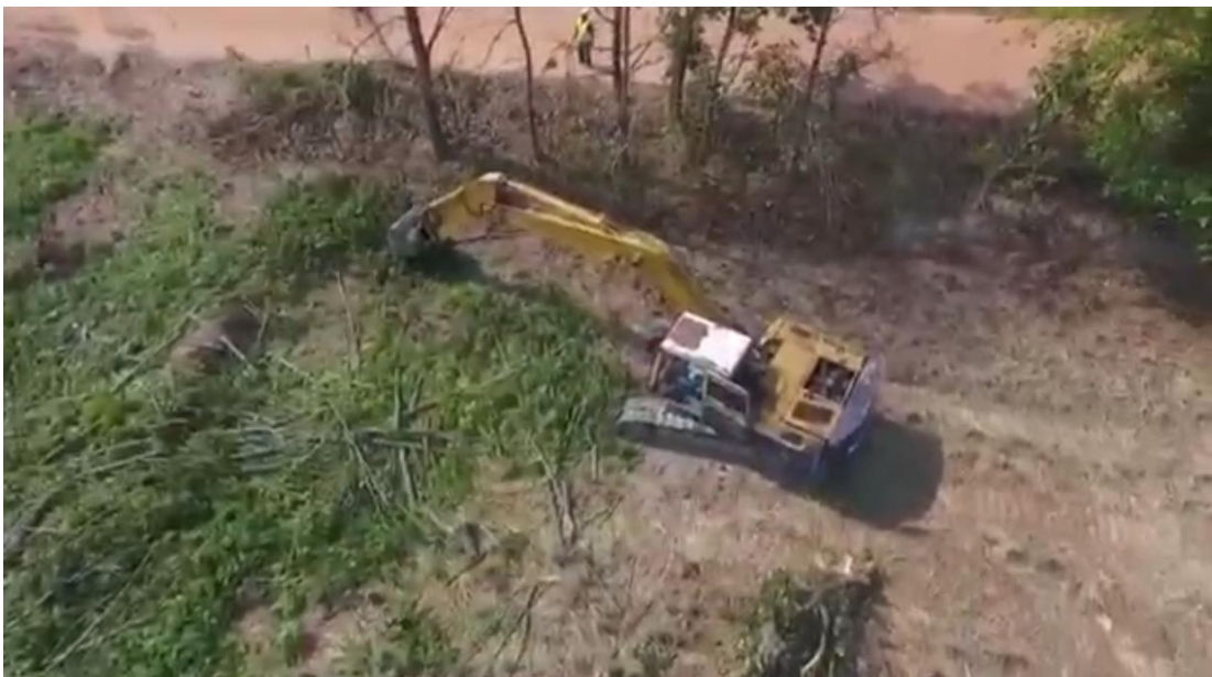
พื้นที่เพื่อทำการก่อสร้างอาคาร o&m และ SUBSTATION (บริเวณแยกทางเข้าวัดด่านพระอินทร์)
