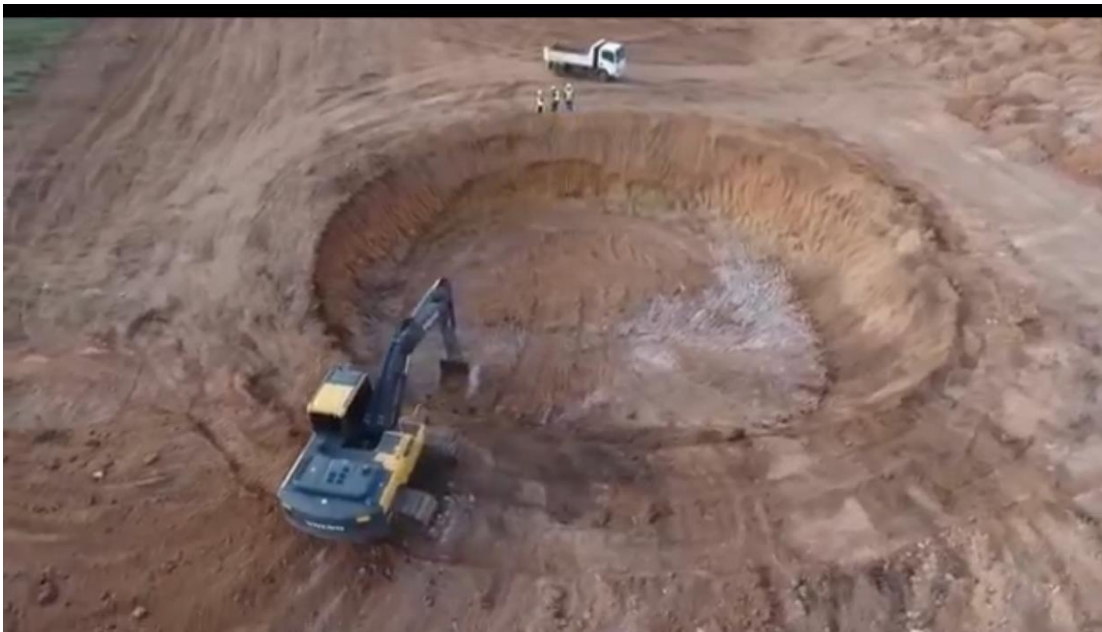
มิถุนายน ๒๕๖๑ การเตรียมพื้นที่สำหรับทำฐานรากของกังหันลม
