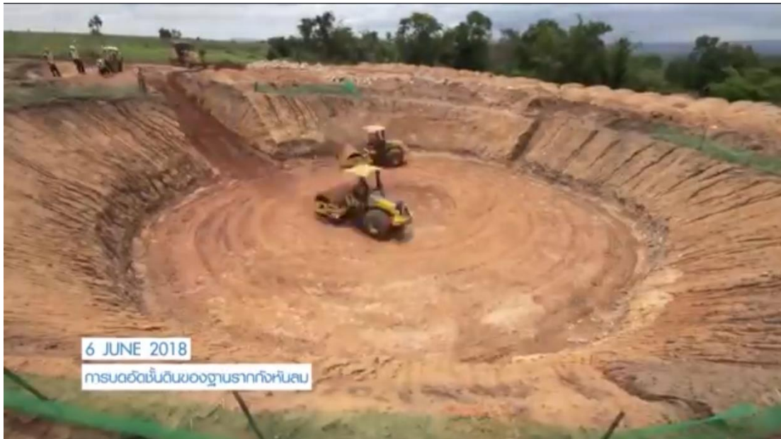
มิถุนายน ๒๕๖๑ จุดพื้นที่สำหรับฐานรากกังหันลม บดอัดและทดสอบตามมาตรฐาน
