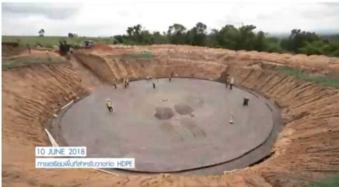
มิถุนายน ๒๕๖๑ เทคอนกรีต
