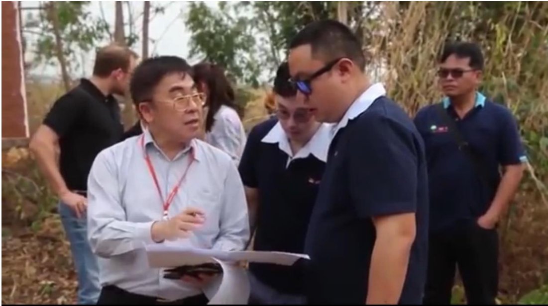
ตรวจพื้นที่และเตรียมพื้นที่เพื่อทำการก่อสร้างอาคาร o&m และ SUBSTATION
