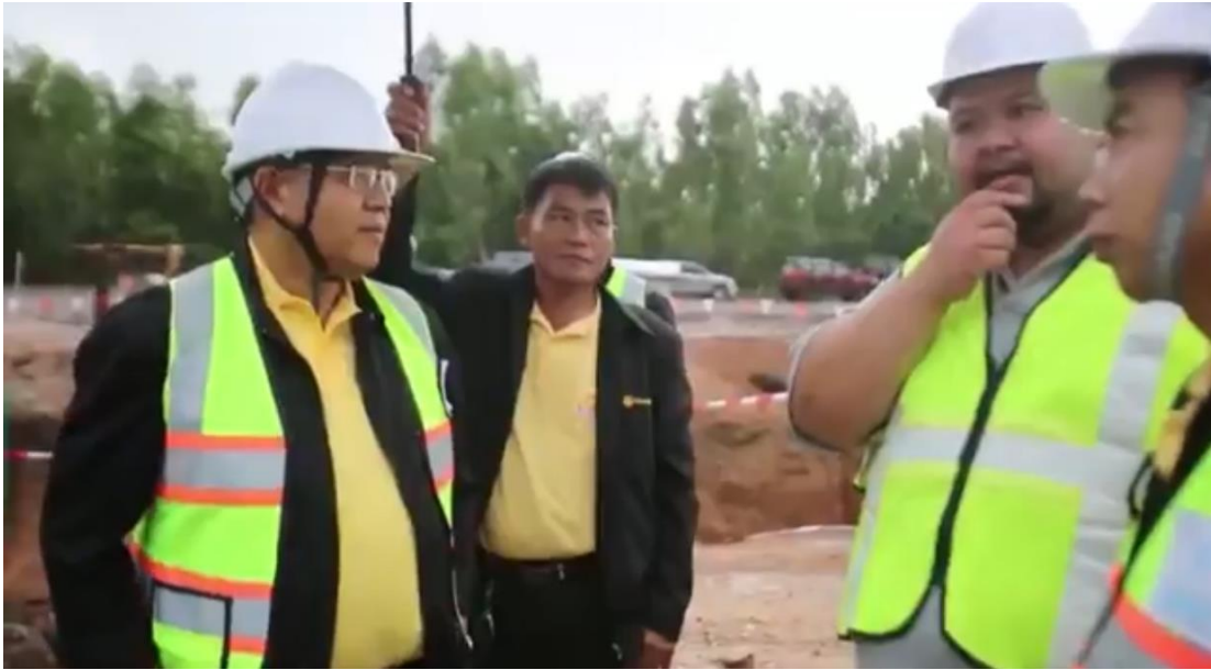
จุดที่เยี่ยมชม อยู่ระหว่างการเทคอนกรีต
