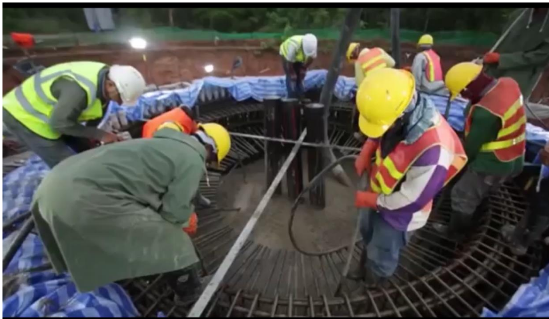
การเทคอนกรีต สำหรับทำฐานรากกังหันลม
